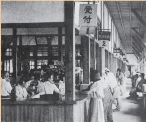
▶洲本市役所の内部(昭和15年)
