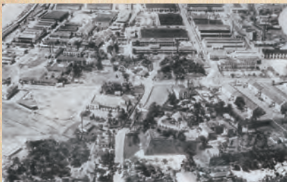
▶「小倉城址」空から見た小倉城内
