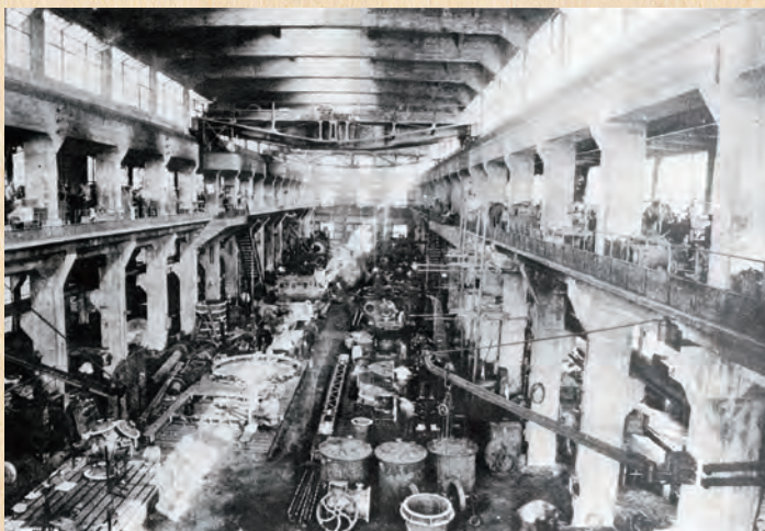
◀「工場群」三池製作所仕上工場
